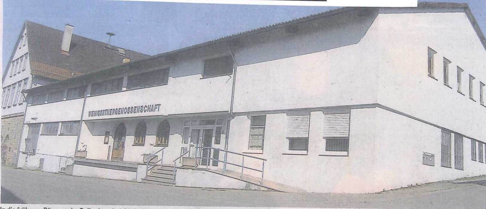
In die früheren Räumen der Raiba (vorn) zieht der Dorfladen ein. Die Michelbacher haben jetzt das gesamte Gebäude in der Ortsmitte zur Verfügung.
